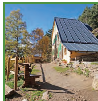
Refugi de Vallferrera
