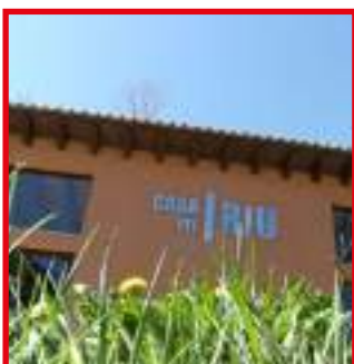
Casa del Riu (House of the River) Cadí-Moixeró Natural Park Archive
